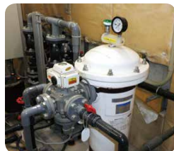
中水道システム
