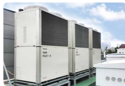
高効率空調機
