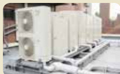
水蓄熱システム
