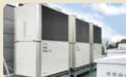
高効率空調機
