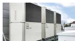
高効率空調機
