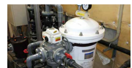
中水道システム
