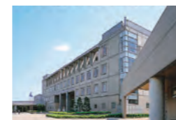
本館 Main Bldg.
