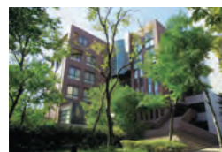
本館 Main Bldg.
