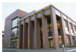
本館 Main Bldg.
