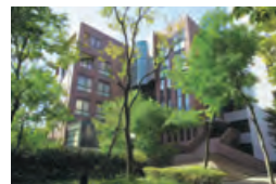
本館 Main Bldg.
