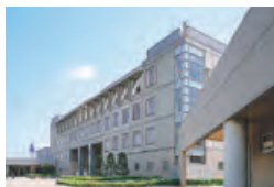
本館 Main Bldg.
